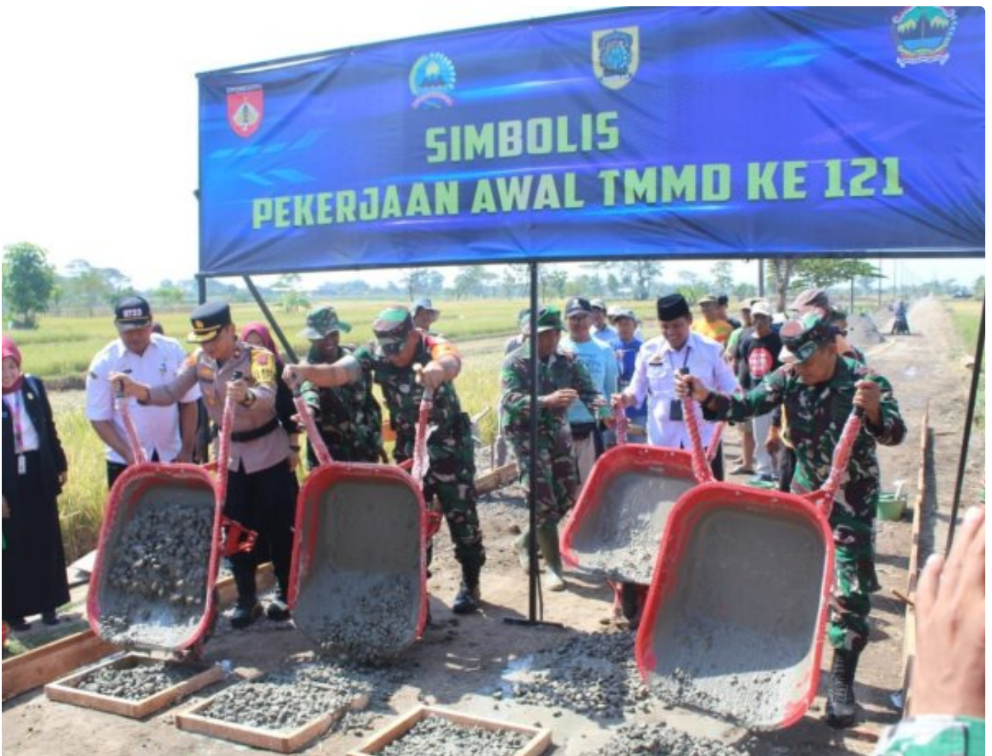
Pengecoran Perdana TMMD Reg 121 dilakukan Forkopimda Klaten
