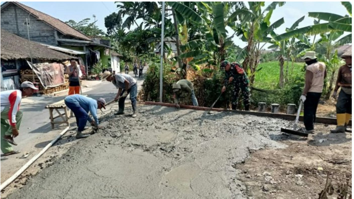
Kemanunggalan TNI Bersama Rakyat, Babinsa Koramil Klaten Utara Gotong Royong Pengecoran Jalan
